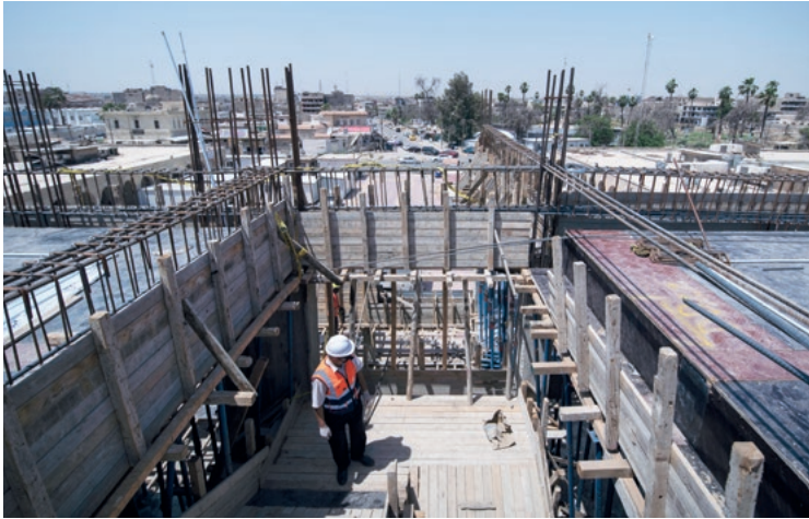
Deutschland unterstützt den Wiederaufbau des zerstörten Gerichtsgebäudes in Mossul. ©UNDP
