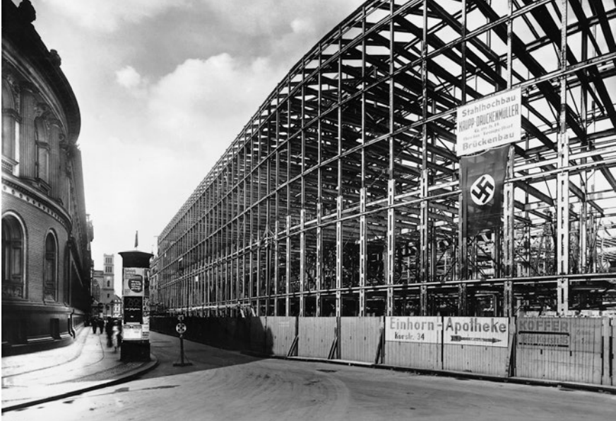
Das Stahlskelett des Erweiterungsbaus an der Kurstraße, 1936
