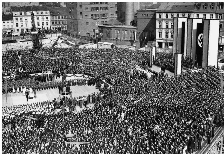
Grundsteinlegung des Erweiterungsbaus. Blick auf die Tribünen, 1934
